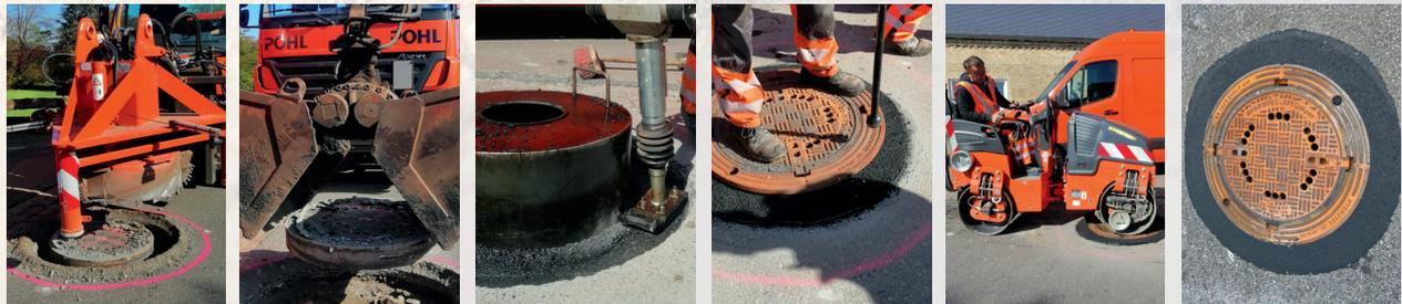
Einbau einer einwalzbaren Schachtabdeckung
